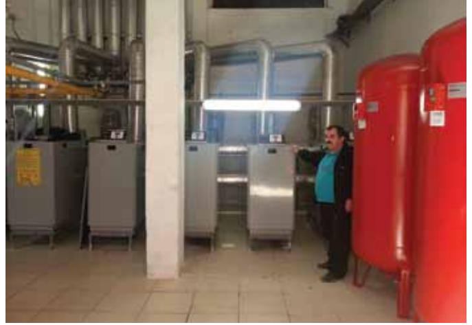
Kastamonu Dr.Münif İslamoğlu Devlet Hastanesi Kazan Dairesi -ALARKO ADK-Y Serisi Yoğuşmalı Döküm Kazanlar
