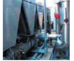
Carrier 30XA Soğutucularının Montajı
