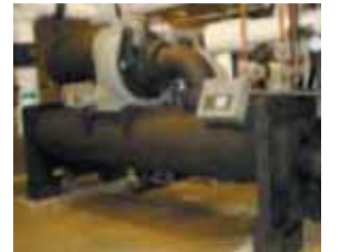
Carrier 30XRV Su Soğutmalı Soğutucunun Montajı
