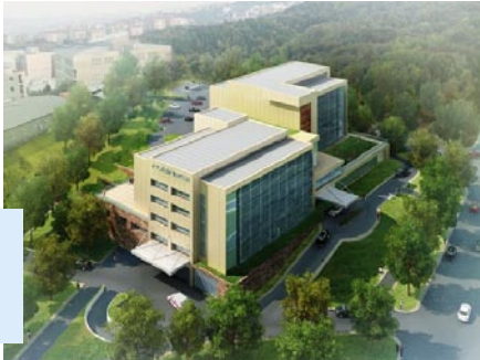
İstanbul Maslak Hastanesi Yapım halinde
