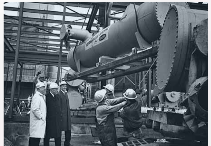
Carrier'in geliştirdiği 1.500 ton kapasiteli su soğutucu ünitesi “Mobil Home Show” fuarında yerleştirilirken (1957).
