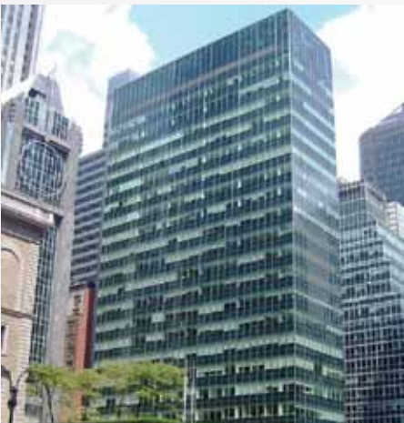
Level House, Newyork, 1952. Carrier'ın gerçekleştirdiği tümüyle bağımsız ve kişisel hava koşullandırma ilk uygulaması
