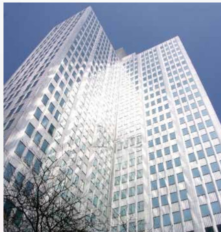
Carrier'ın Pittsburg'da gerçekleştirdiği Gateway Center, ilk kez tüm binada bağımsız hava koşullandırmanın uygulandığı en büyük projeydi
