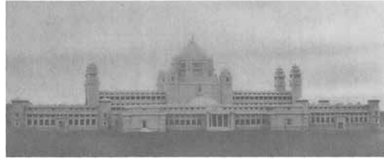
Chittar Sarayı. Hindistan'da konforlu soğutma, buz üretme ve dondurma yapma olanaklarının Carrier ile sağlandığı saray.
