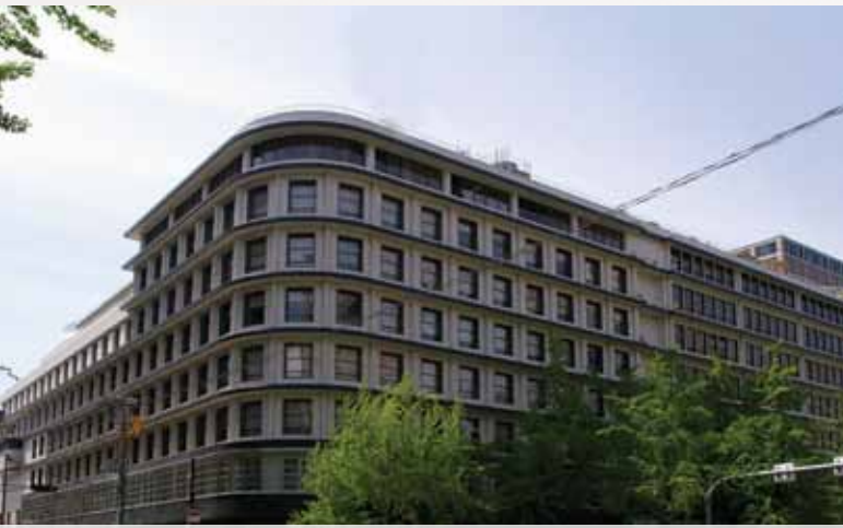
Japonya'da Osaka Gaz şirketinin binasına kurulan Carrier'in Weathermaster sistemi ile Japonya'da ilk kez bir binanın tümüyle havası koşullandırılmıştı.
