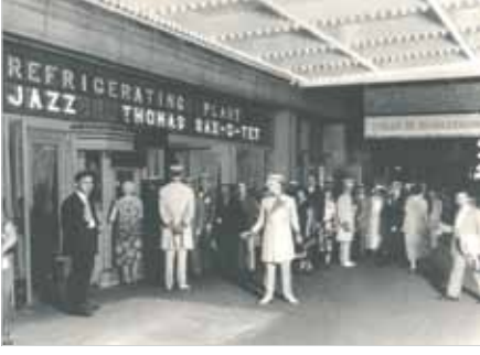
Fotoğraf 2- New York'ta Rivoli Tiyatrosu. O zamanlar söylendiği gibi "soğutma fabrikası"yla soğutma yapan ilk su soğutucunun yerleştirildiği salondur.
