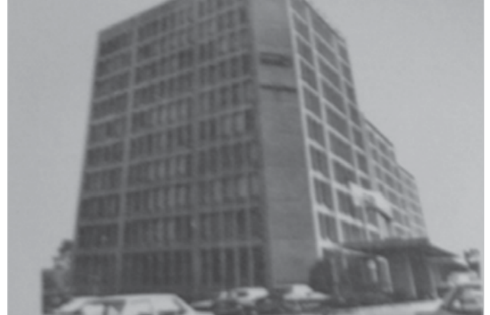
Alarko Holding'in Maslak'taki binası
