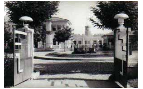
Cumhuriyet'in ilk yıllarında kurulan sanayi tesislerinden biri olan Sümerbank Malatya Bez Fabrikası'nın giriş kapısı ve idare binası.
