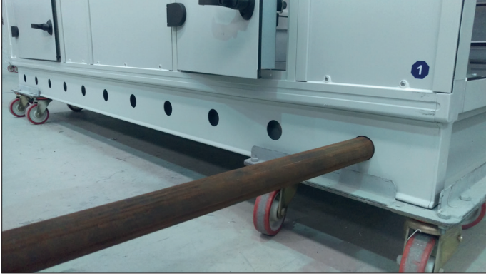
Şekil 6. Kaldırma çubuklarının bağlanması - 2
