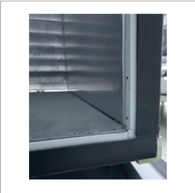
Şekil 20. İzolasyon bant uygulaması
