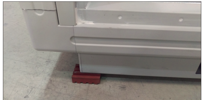
Şekil 10. Titreşim önleyici kauçuk levha
