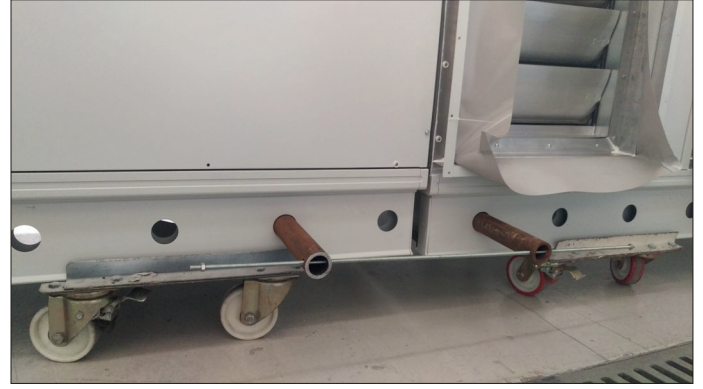
Şekil 12. Dış açılmış çubuk kullanarak bölümleri birleştirmek
