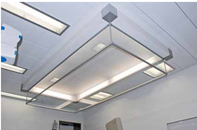
CH-Yverdon-les-Bains, eHnv – Hôpital Yverdon-les-Bains
