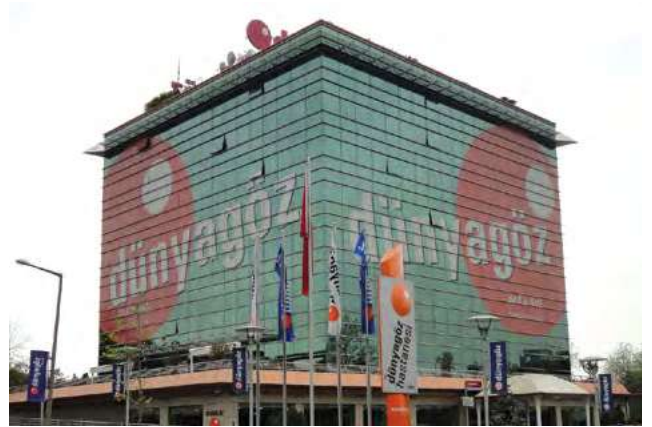
Dünya Göz Hospital, Etiler - İstanbul
