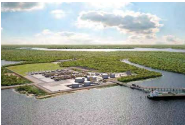
Ichthys Onshore LNG Facility - Australia
