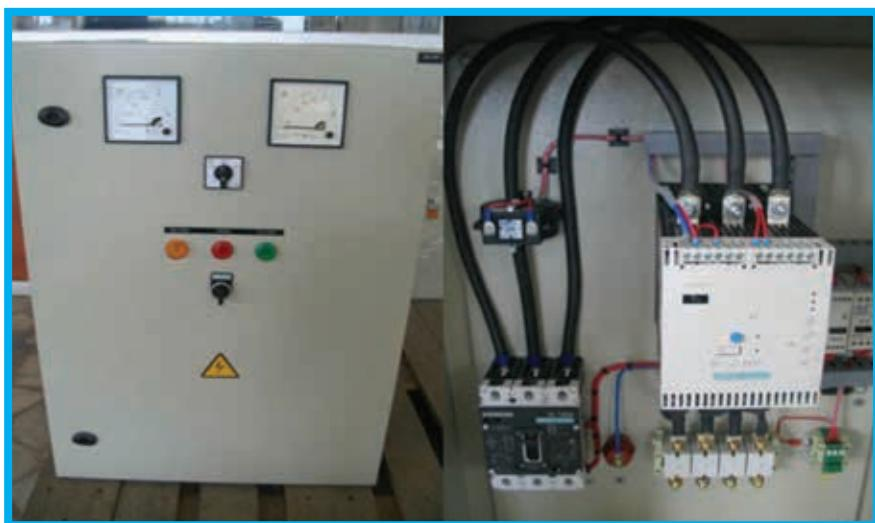
Standart elektrik panolarına alternatif, Soft Starter Yol Verme özellikli panoların kullanımı ile;
