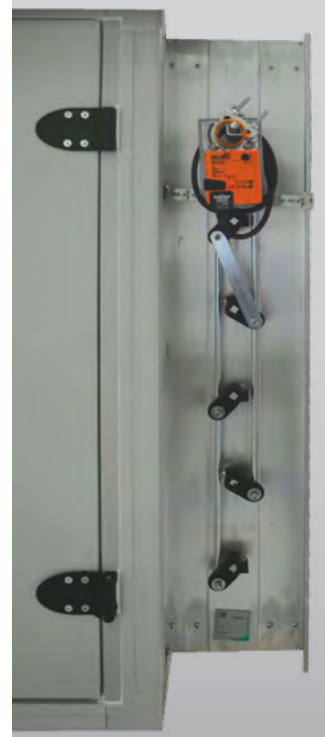
Santral içi ve dışı damper motoru
