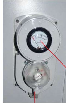
Fark basınç ölçer (Pressure Switch)
