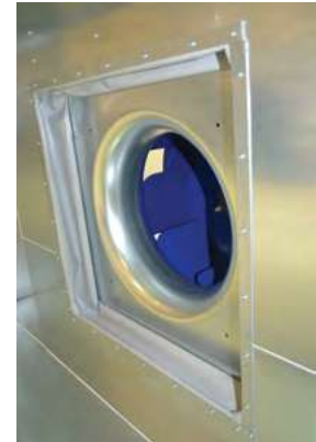
M0 sınıfı fan esnek bağlantısı (M0 fire class fan flexible connection)
