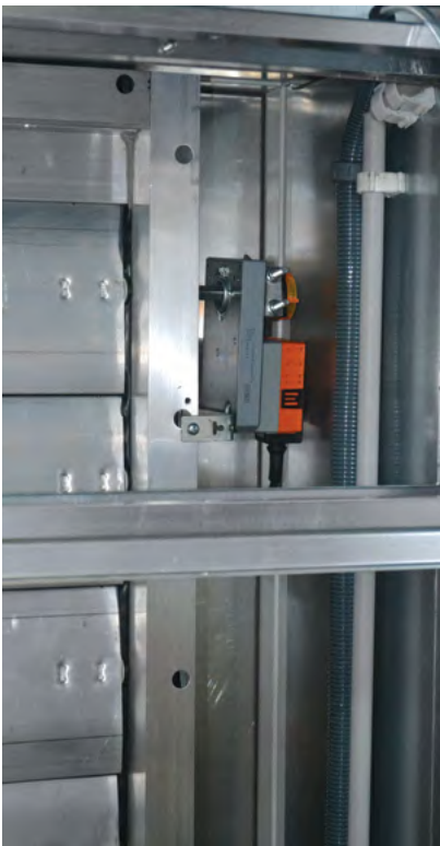
Santral içi ve dışı damper motoru
