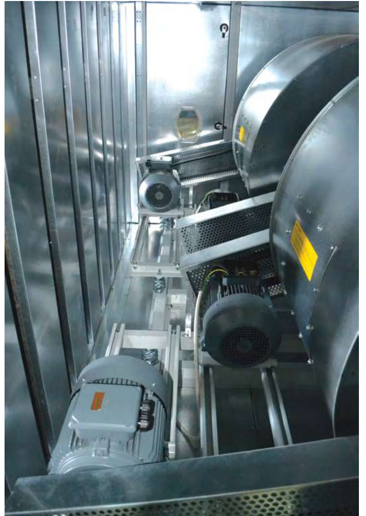
İkili fan ve yedek motor
