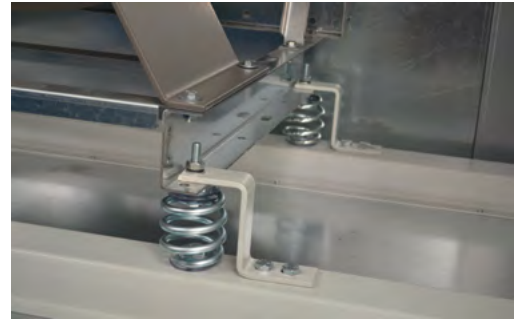
Yaylı sönümleyici (spring anti vibration mounts)
