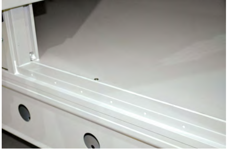
Santral tabanı ile aynı yükseltide kapı eşığı
