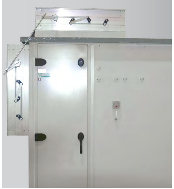
Damper bağlantı mili (Coupling rod for dampers)
