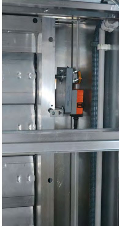
Santral içi ve dışı damper motoru
