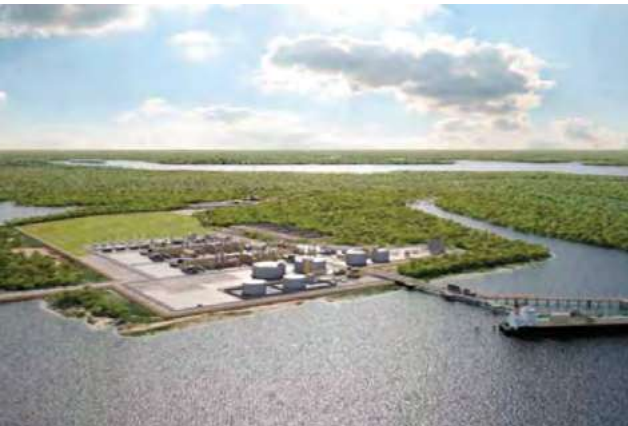
Ichthys Onshore LNG Tesisi - Avustralya
