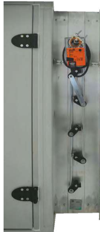
Santral içi ve dışı damper motoru
