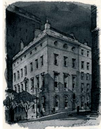
ABD Yeşil Bina Konseyi tarafından CFR binasına verilen LEED Gold logosu (üstte). CFR binasının yeni bölümü (yanda solda) ve eski koruma altındaki tarihi binası (yanda sağda).
